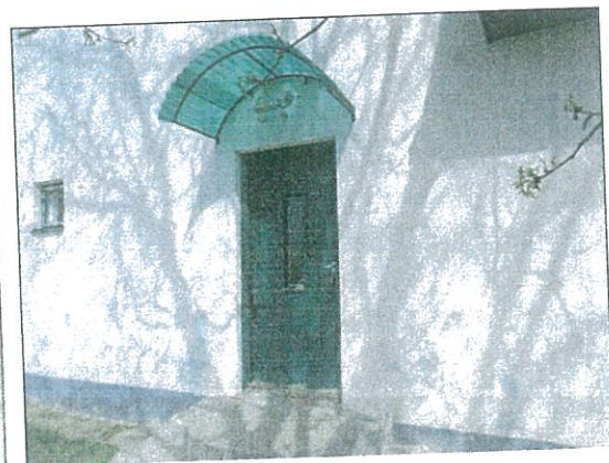
Felújítandó rész bejárata
