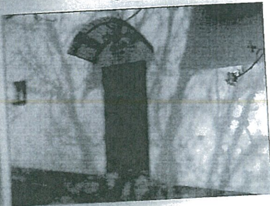
Felújítandó rész bejárata
