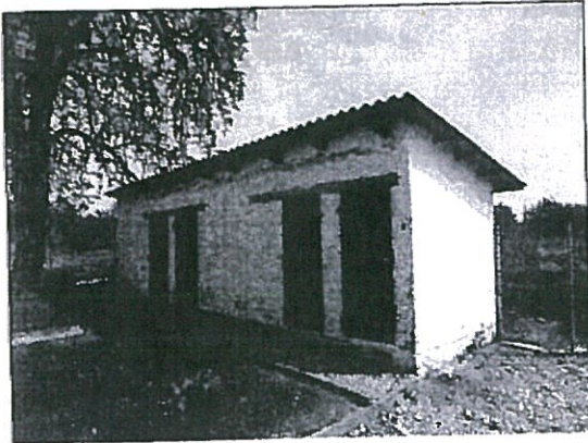
Gazdasági épület (nem értékelt)
