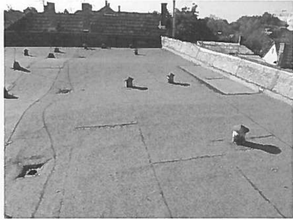
szigetelés utólagos javítása több helyen a tetőn
