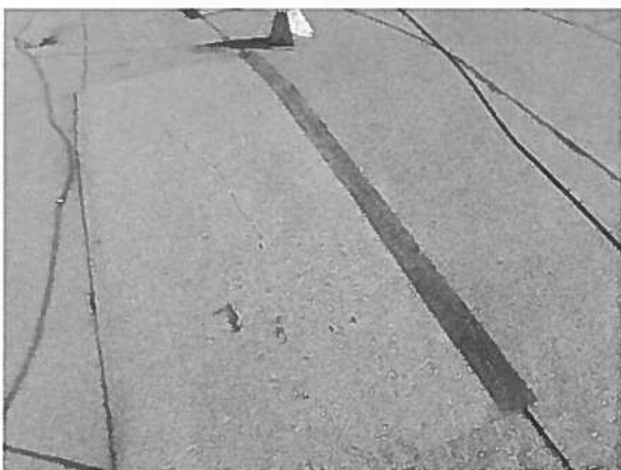
szigetelés utólagos javítása
