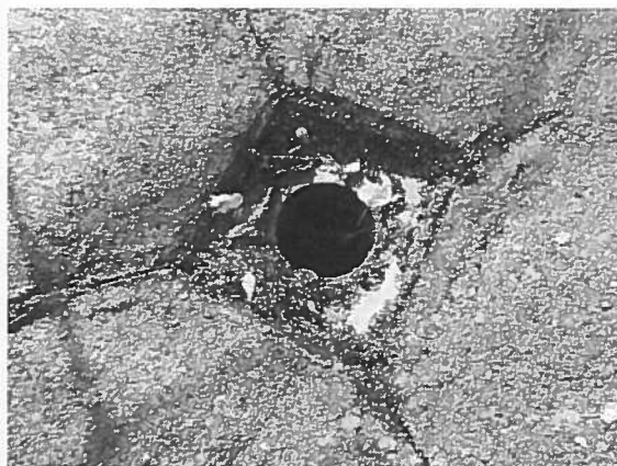
megrepedt, meggyűrődött szigetelés a lefolyók körül, hiányzó lombkosár
