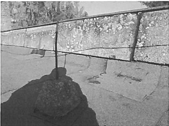
attika falak szigetelése nincs megoldva, a tetőszigetelés nem fordul fel több helyen az attika falra
