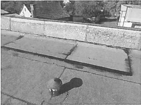
szigetelés utólagos javítása több helyen a tetőn, a javítások ellenére több helyen beázik
