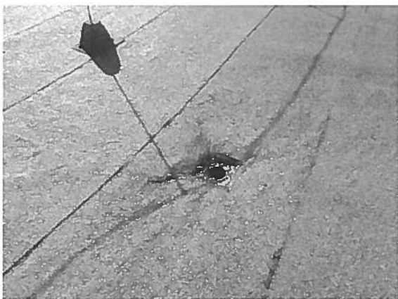
megrepedt, meggyűrődött szigetelés a lefolyók körül, hiányzó lombkosár
