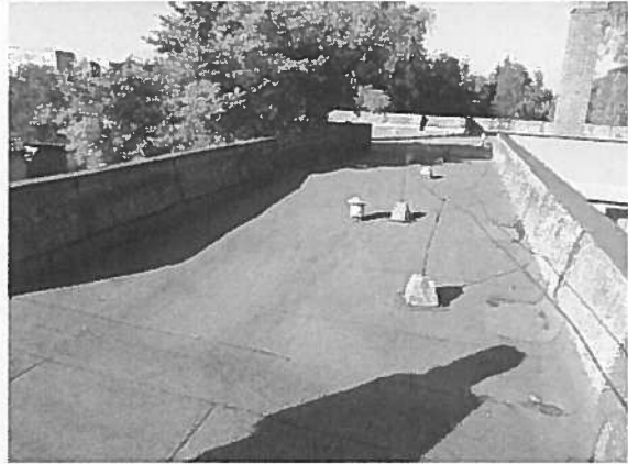
szigetelés utólagos javítása több helyen a tetőn, a javítások ellenére több helyen beázik
