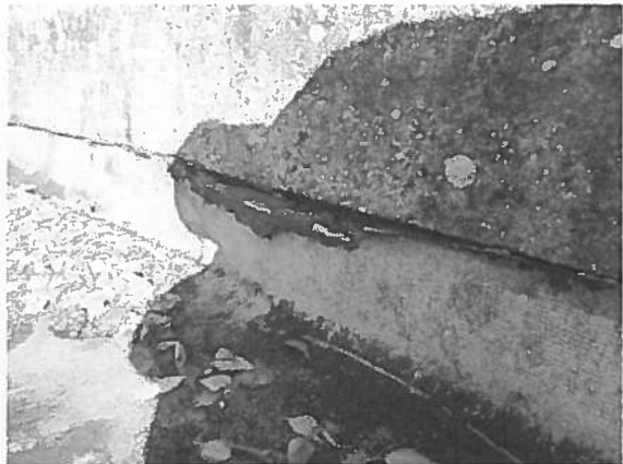
attika falak szigetelése nincs megoldva, a tetőszigetelés nem fordul fel több helyen az attika falra
