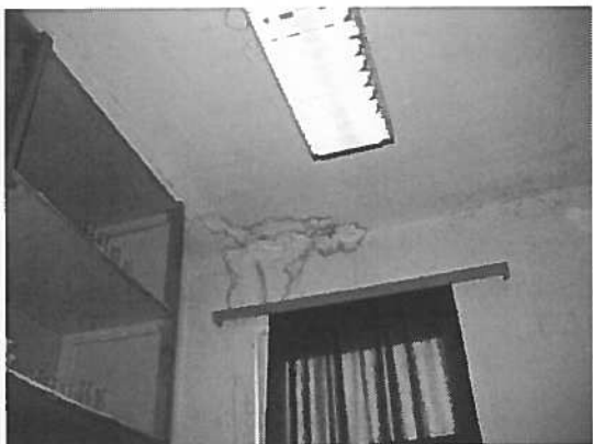
Az utcáfronton az emeleti fizika szertár beázott a vihar következtében. Az északi lépcsőház feletti földém is beázott.
