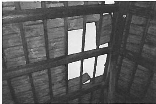
A viharos szél az északi szárny udvar felőli tetőfelületéről 2-3 m 2 felületen felszakította a cserépfedést.
