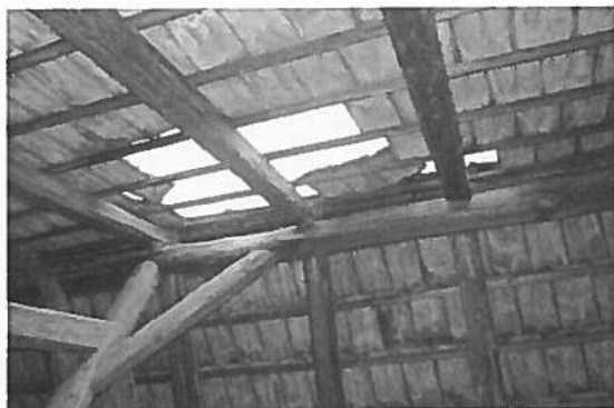
A viharos szél az északi szárny udvar felőli tetőfelületéről 2-3 m 2 felületen felszakította a cserépfedést.
