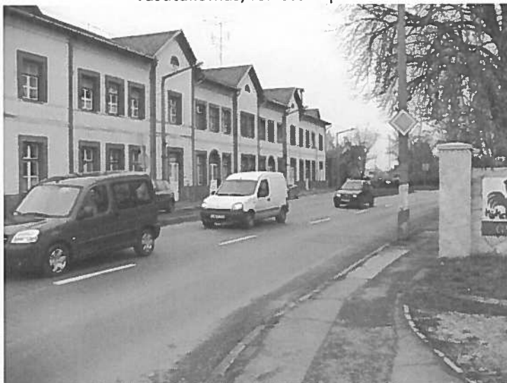
vasútállomás, felvételi épülete
